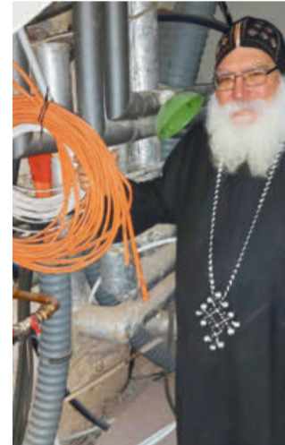
Unterhalb des koptischen Klosters entsteht der Gewölbekeller. „Noch sieht das hier aus wie eine große Baustelle. Coronabedingt gibt es Lieferengpässe. Im nächsten Jahr wollen wir das Projekt Keller abschließen“, freut sich Damian auf die besonderen Räumlichkeiten.
