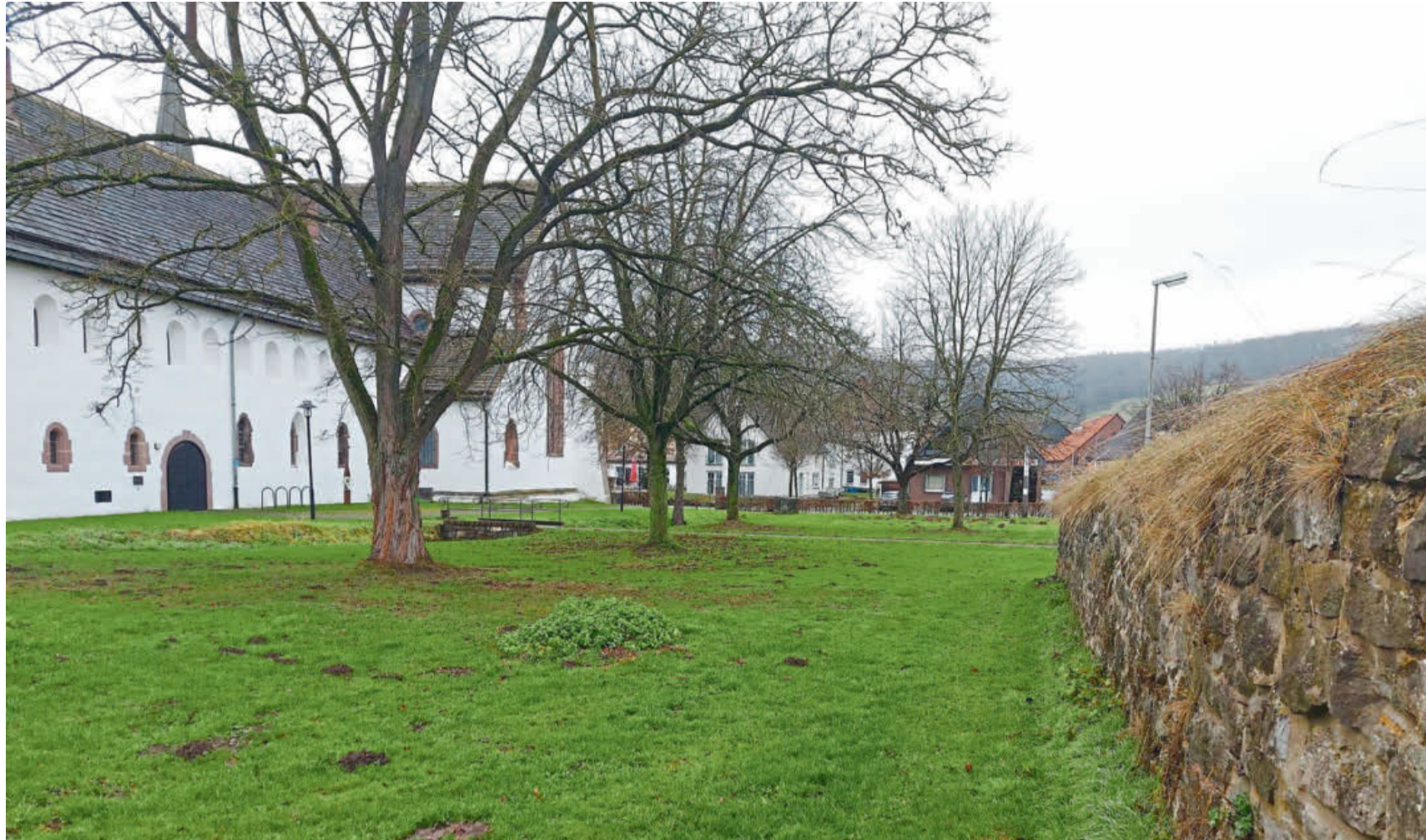
Entlang der Klostermauer (rechts) und des katholischen Pfarrheims (links) wird in Brenkhausen der Klostergarten entstehen. Die Arbeiten werden in Kürze beginnen. Im Juni 2022 soll das 200.000 Euro-Projekt abgeschlossen sein. Das Schelpedorf wird 2022 1200 Jahre alt. Fotos: Jürgen Drüke
