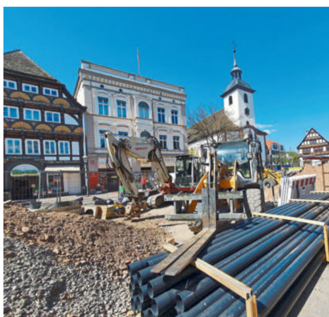
Dieses Bild ist im April entstanden, seitdem sind die Arbeiten gut vorangekommen, wohl aber nicht schnell genug. Foto: Robrecht
