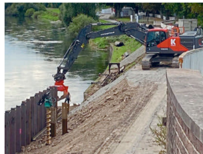
Am Ufer nahe des Weserradwegs südlich der Brücke werden zurzeit neue Spundwände gesetzt. Die Arbeiten laufen auf Hochtouren.
