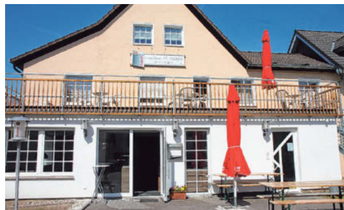
Umfassend saniert: Im Erdgeschoss des Gästehauses St. Markus wird am 1. Mai das neue Restaurant St. Markus eröffnet, das auch für junge Gäste ein attraktives Angebot bereit hält.
