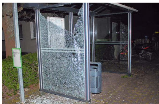
Zerstört: Die Scheibe im Wartehäuschen an der Schlesischen Straße in Höxter. FOTO: POLIZEI
